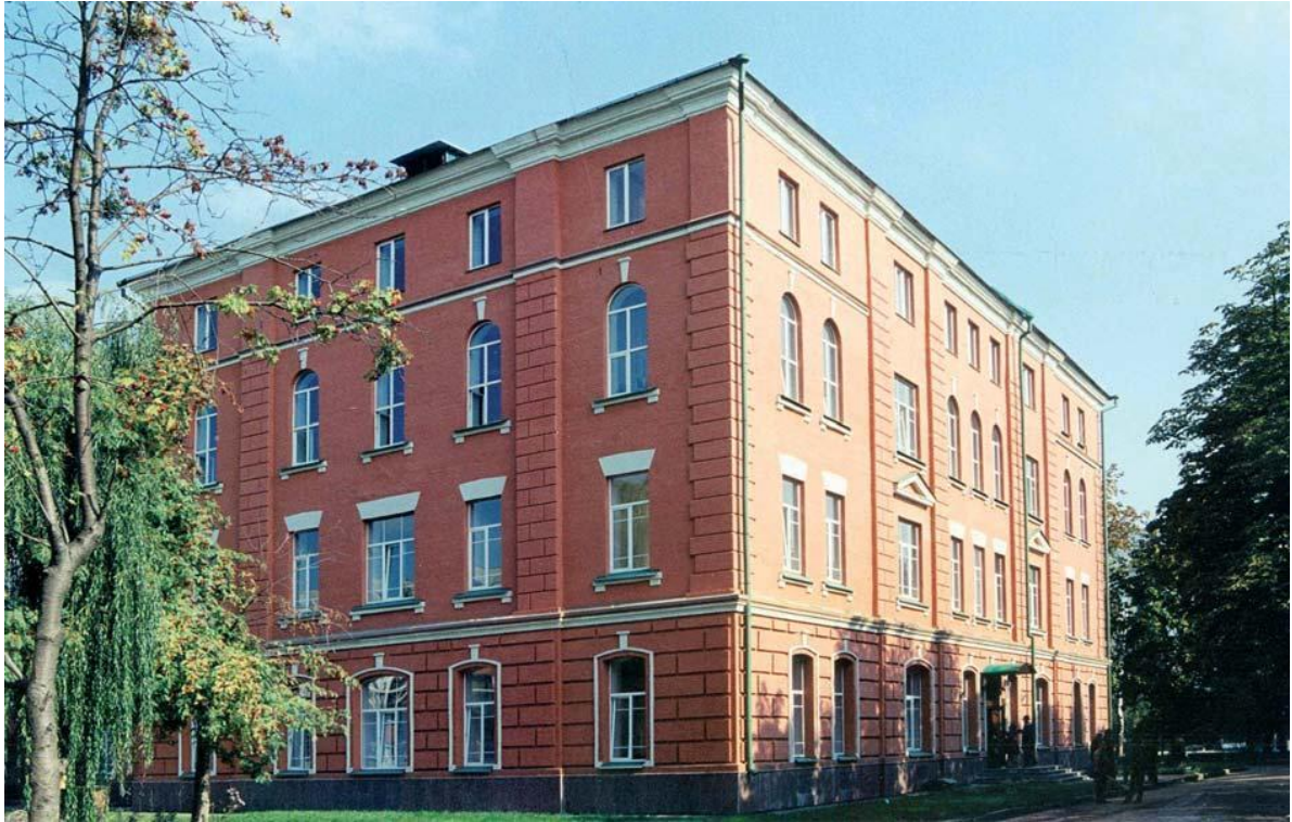
На фото: навчальний корпус господарсько-правового факультету, вул. Пушкінська, 79/2.
